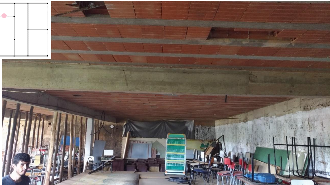
Figura 11 - Visão Geral das Estruturas sob o Palco
