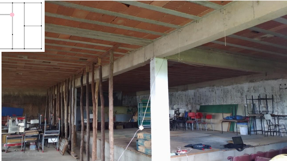
Figura 12 – Visão Geral das Estruturas – Pilares, Vigas e Laje Treliçada.
