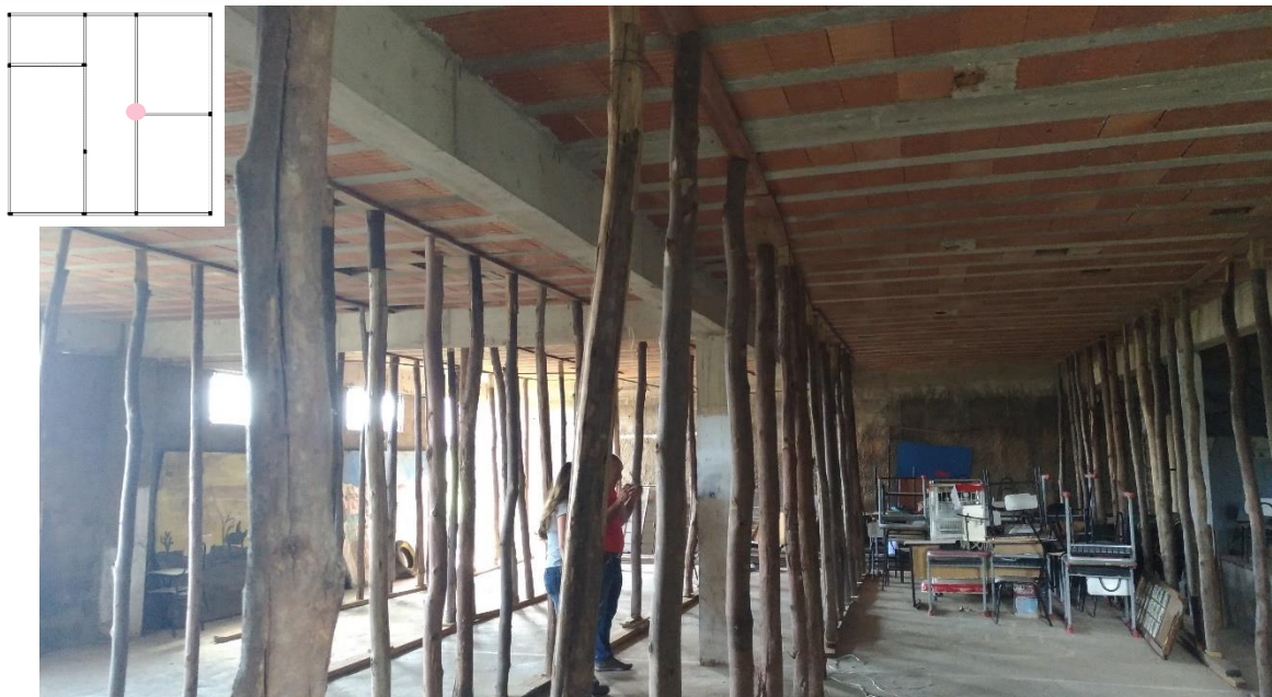
Figura 13 – Visão Geral do Escoramento Provisório
